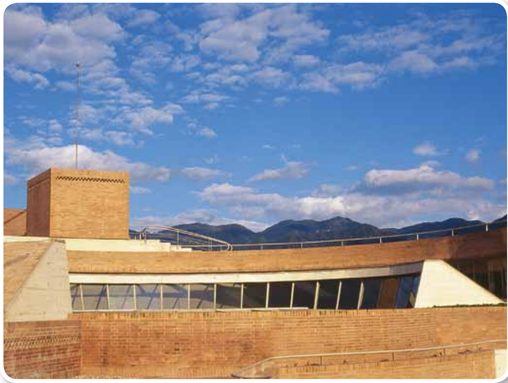
Biblioteca Virgilio Barco, diseñada por el arquitecto Rogelio Salmona para la Red de Bibliotecas de Bogotá.
