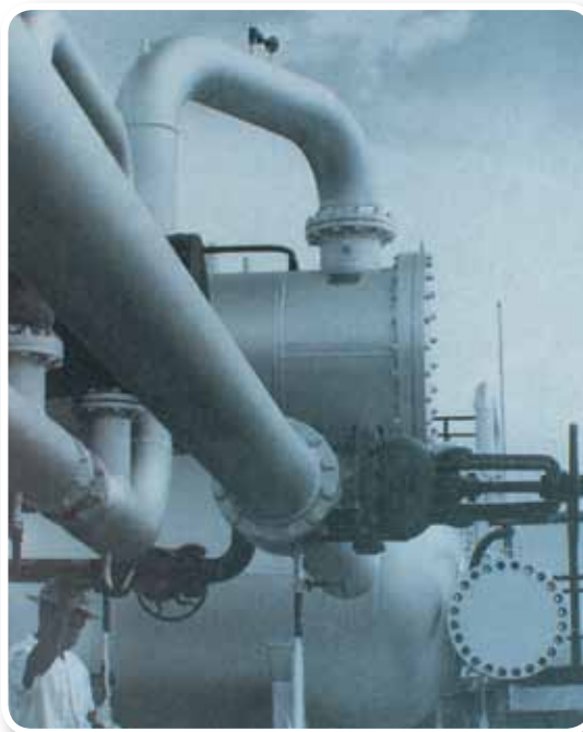
Leo Matiz. Instalaciones petroleras en 1948.
