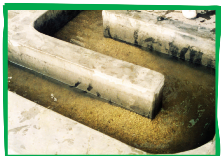
Canal de carreteo
