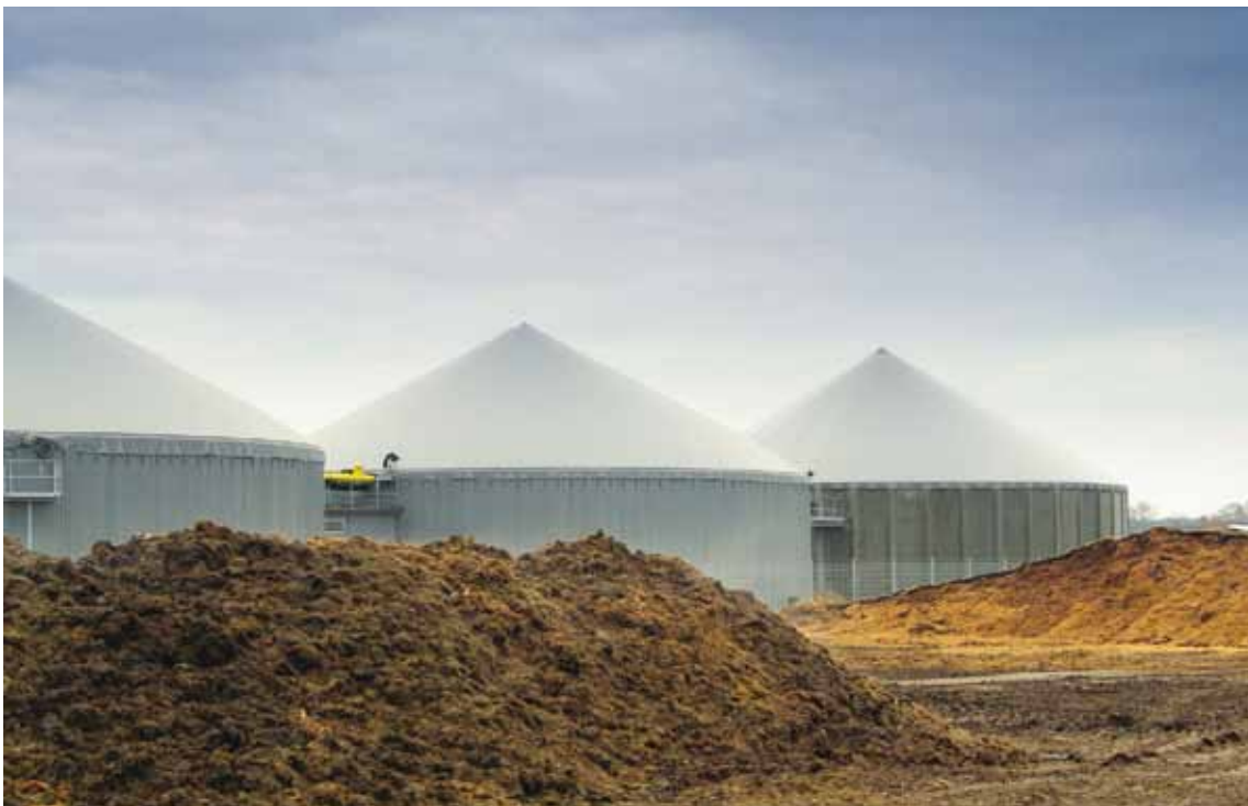
Planta de Biogás.
